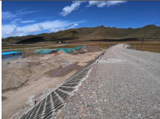
路基边坡施工
