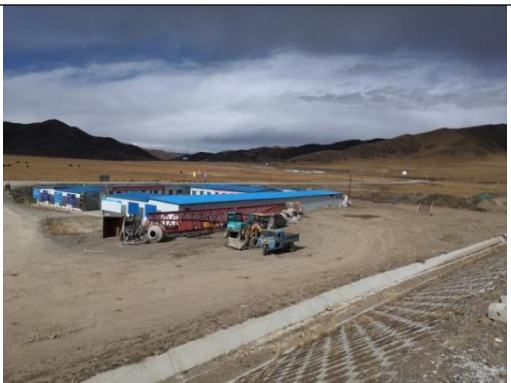
临时施工营地
