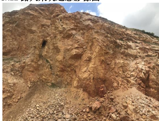
CK10 露天采坑局部塌陷坑
