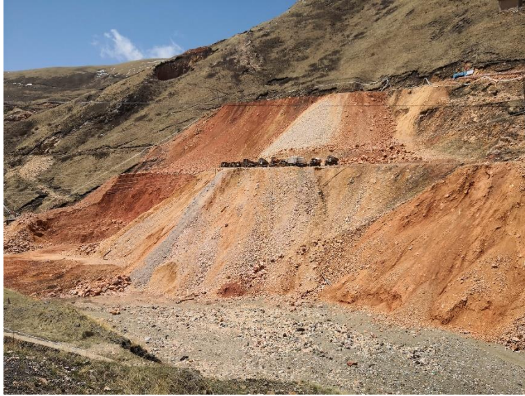
图 2-18 井口工业场地边坡
