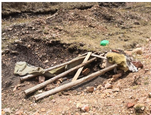
拆除后残留建筑垃圾
