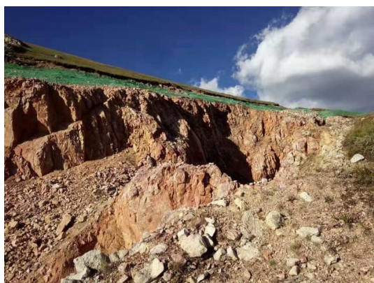
CK3 露天采坑东侧区域
